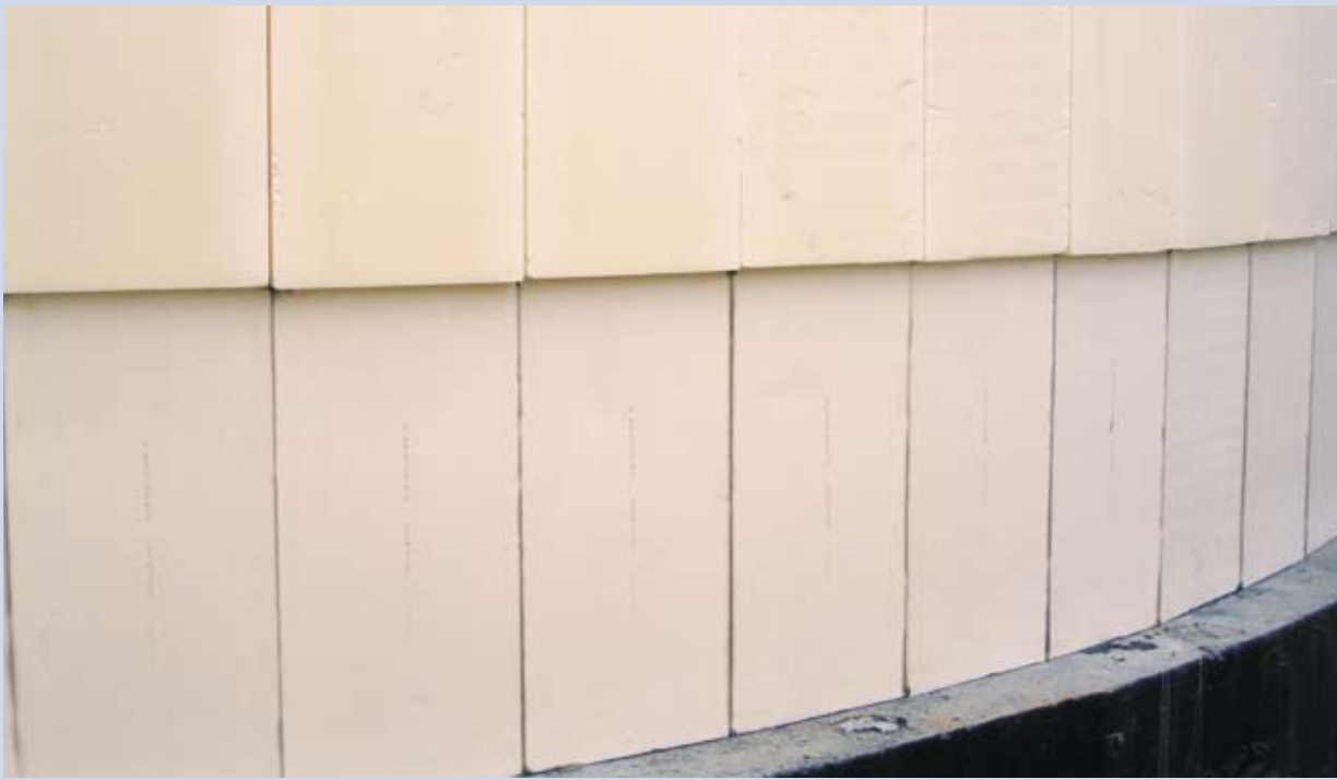
2.3.3 Termoizolacja ściany fundamentowej budynku podpiwniczonego w gruntach słabo przepuszczalnych
