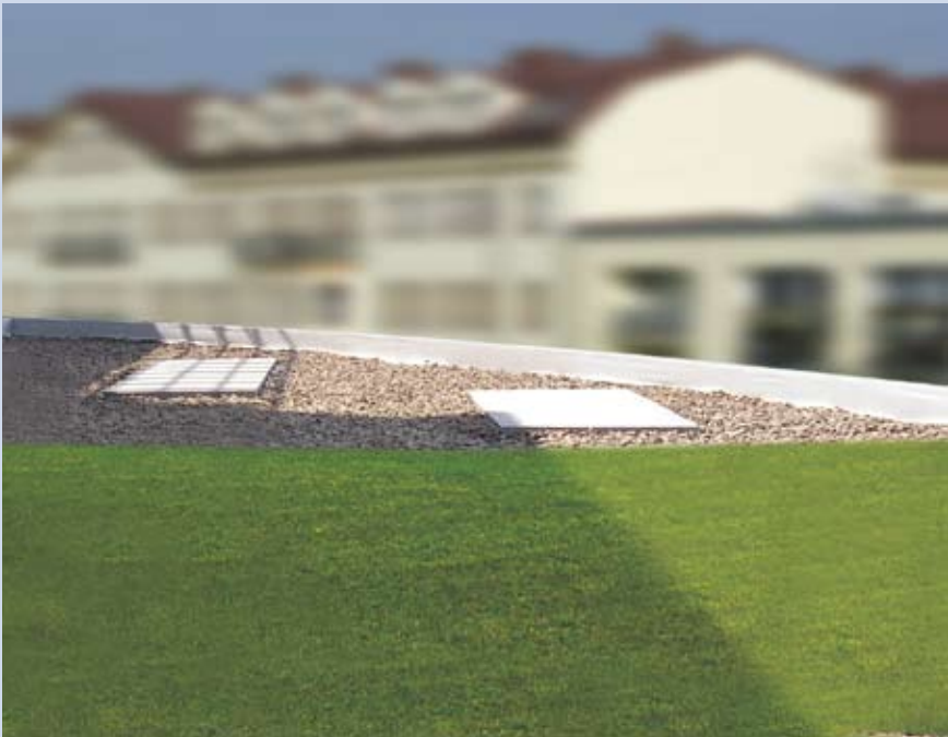
Przykład rozwiązań dachu odwróconego z zielenią ekstensywną
