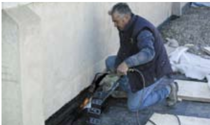
Montaż hydroizolacji
