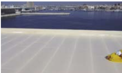
Układanie drugiej warstwy termoizolacji z płyt URSA XPS
