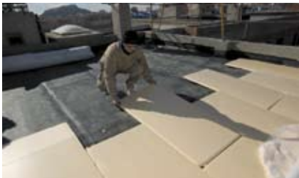
Układanie warstwy termoizolacji z płyt URSA XPS
