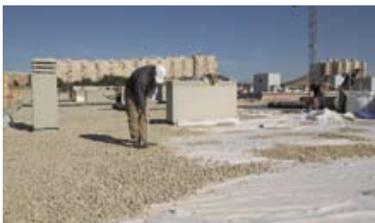
Układanie warstwy balastowej żwirowej
