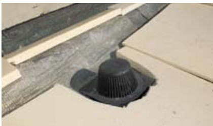
Obróbka spustu dachowego
