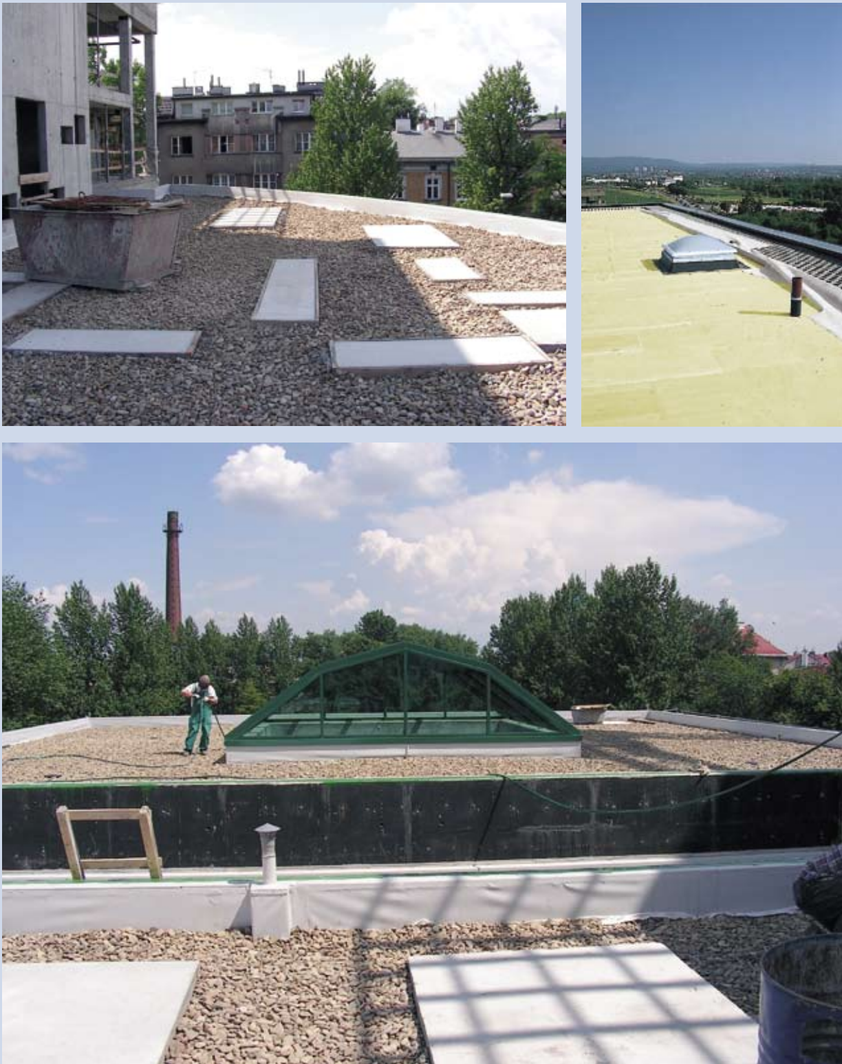
Przykład rozwiązań dachów odwróconych z warstwą balastową żwirową
