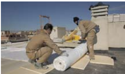
Układanie warstwy filtracyjnej – geowłóknina
